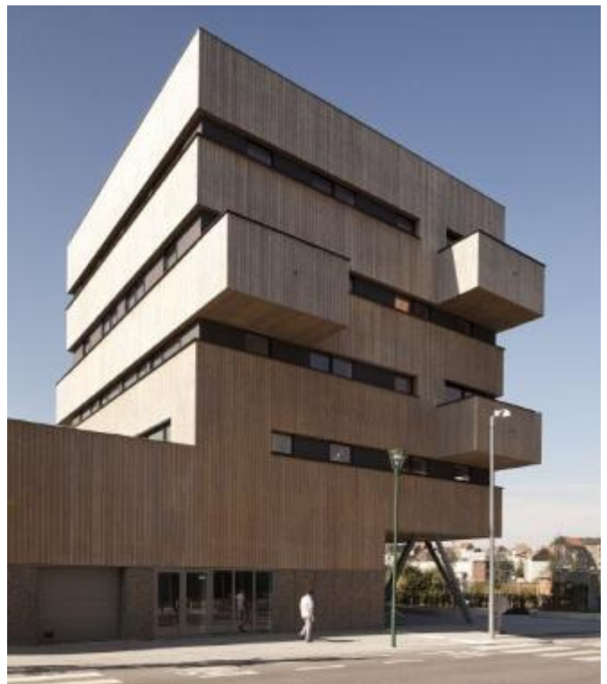
Bâtiment passif, avenue J. Dubrucq 224, à Molenbeek
